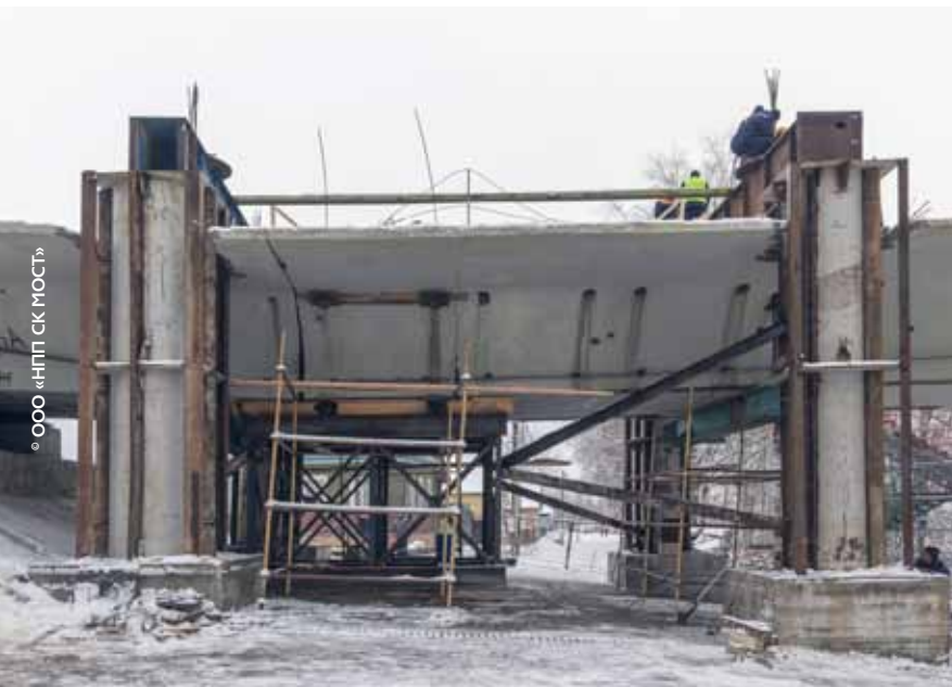
Реконструкция моста через реку Западную Двину
