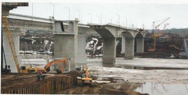
На одном из объектов – мост через Вятку, г. Мамадыш
