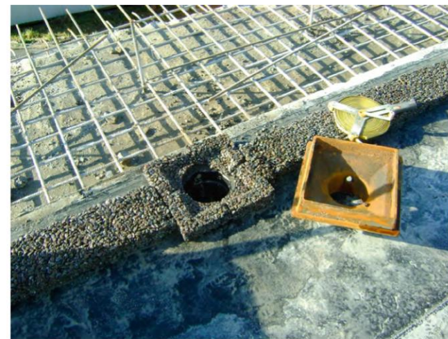
Дренажная система в конструкции дорожной одежды
