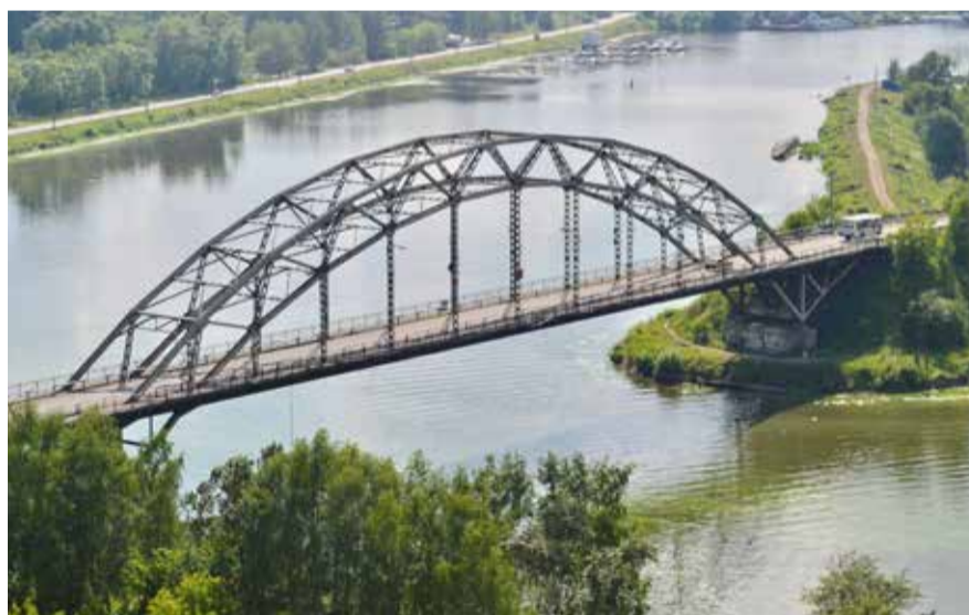
Никольский мост в г. Кинешме
