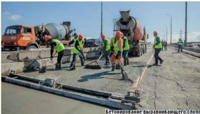
Бетонирование выравнивающего слоя
