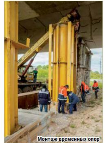
Монтаж временных опор
