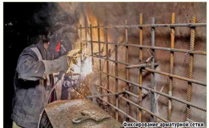
Фиксирование арматурной сетки
