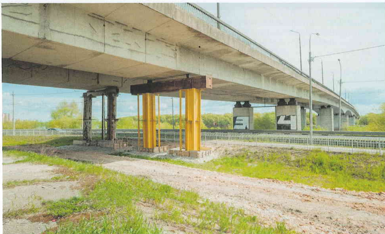
г. Великий Новгород. Временные опоры с траверсой
