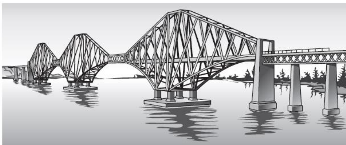
Рис. 10.4. Фортский мост с пролетами по 521 м (1890 г.)
