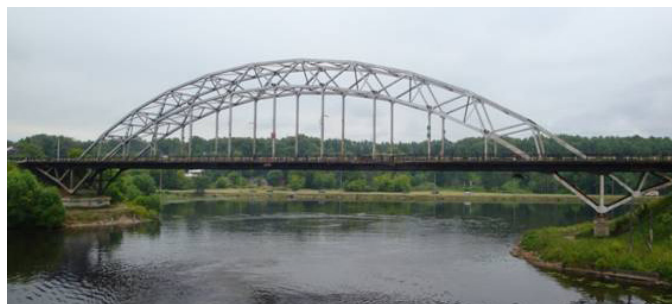
Рис. 3. Никольский мост в г. Кинешма
