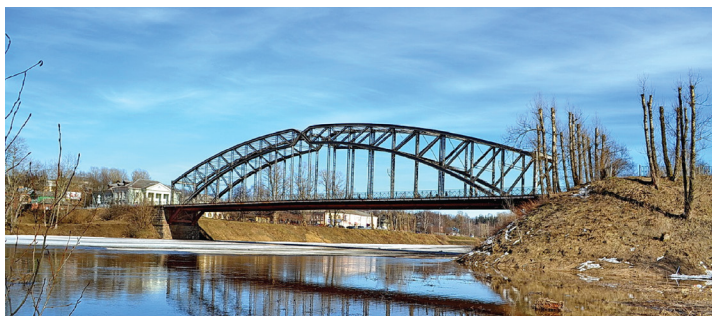
Большой металлический арочный мост в центре города Боровичи
