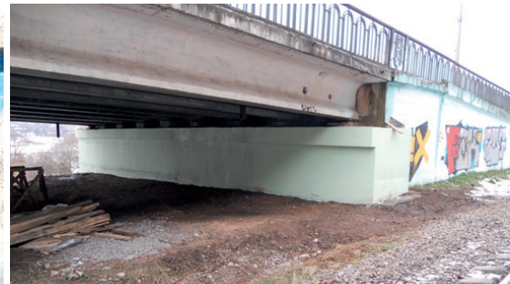
Устой после ремонта - лето 2011 г.
