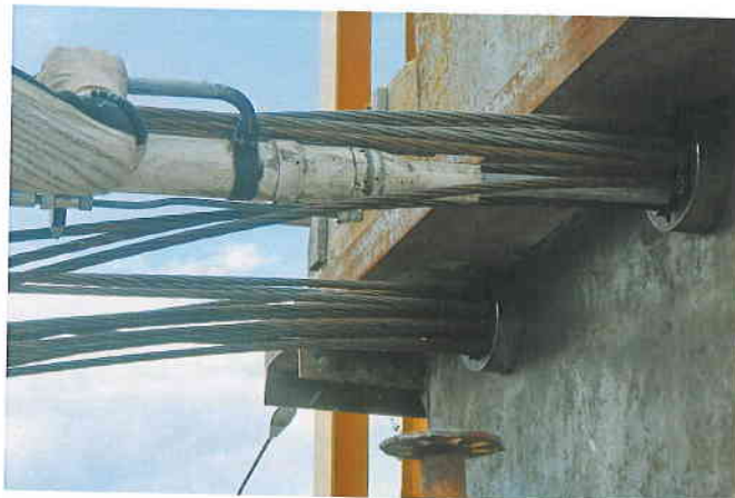
Фото 2. Установка металлического листа, натяжение прядей
