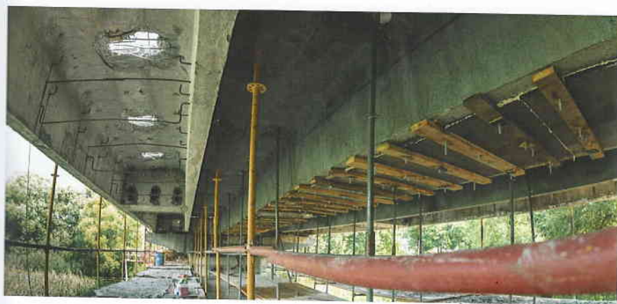
Фото 9. Работа с подвесных подмостей
