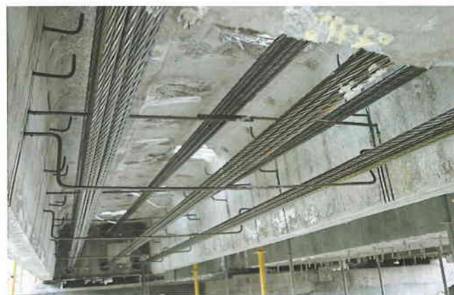
Фото 5. Канаты преднапряжены 6х12 прядей Ø 15,7 мм
