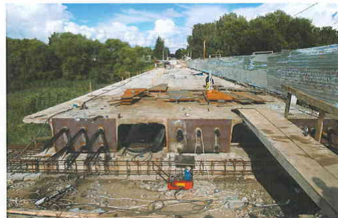
Фото 6. Преднапряжение пучков в коробке
