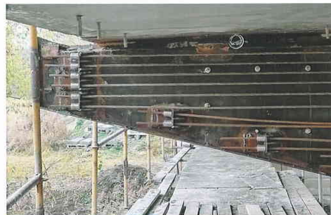
Фото 7. Установка и натяжение арматурных канатов на ригелях
