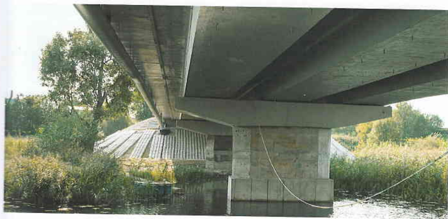
Фото 10. Вид снизу после ремонта
