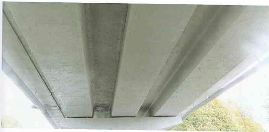
Фото 8. Вид на пролетное строение снизу после ремонта
